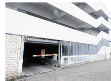
Das Parkhaus wird renoviert und soll einen Durchgang ins Center erhalten.
