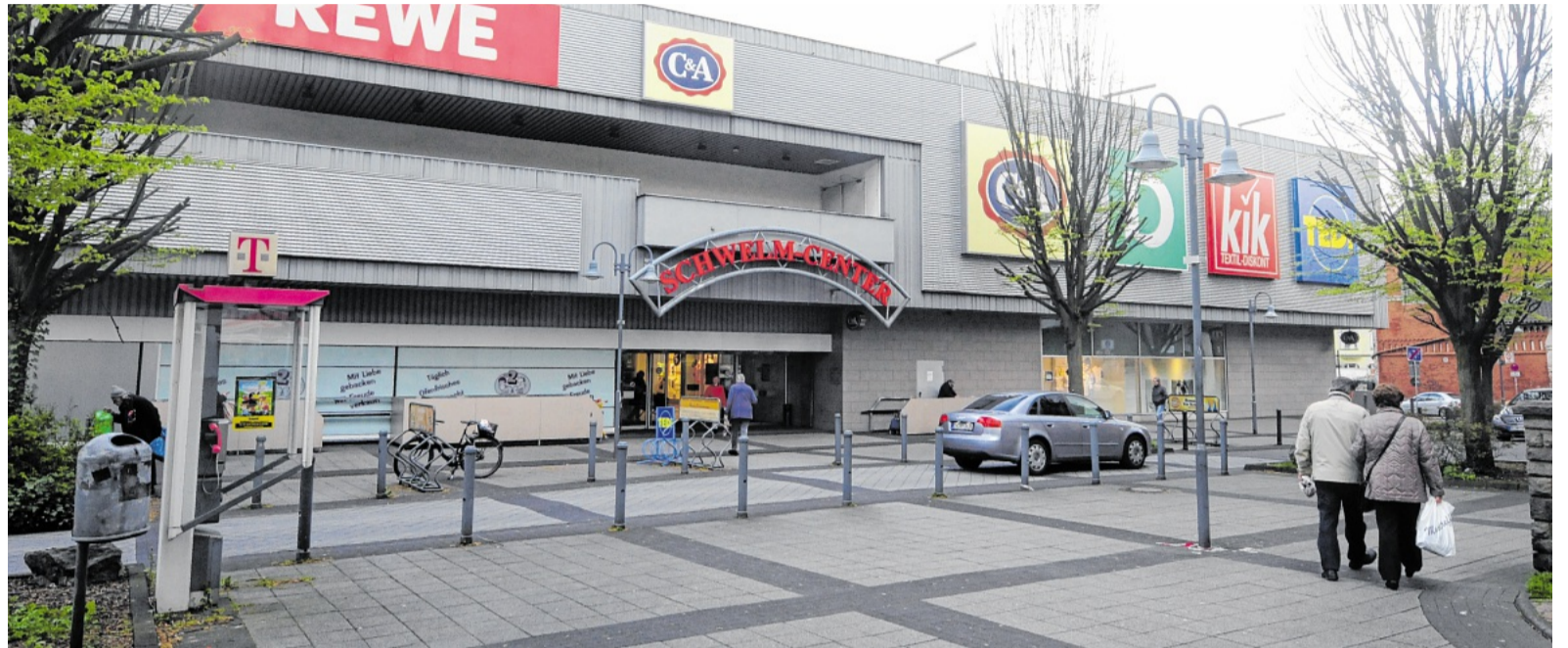
Das Schwelm-Center gammelt seit Jahrzehnten vor sich hin. Nun hat Kintyre Management den Gesamtkomplex inklusive Parkhaus gekauft und wird einen hohen siebenstelligen Betrag investieren.
