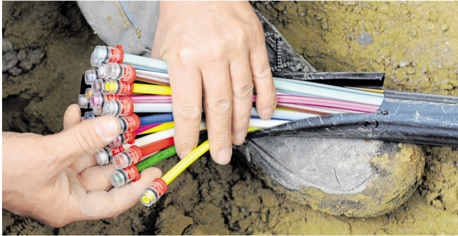
Solche Glasfaser-Kabel will die Telekom 2017 in drei Gebieten von Wetter verlegen, über Kabelverzweiger werden dann die Haushalte erreicht. FOTO: PETER KNEFFEL
